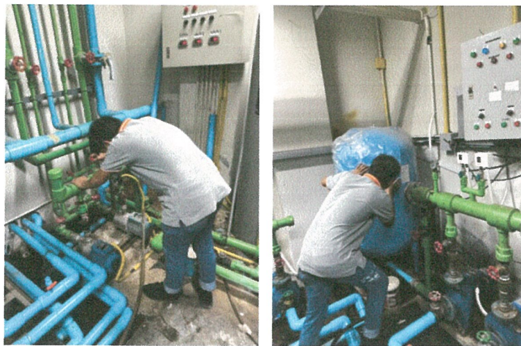
รูปภาพที่ 2.17 เจ้าหน้าที่ตรวจสอบระบบแจกจ่ายน้ำ
