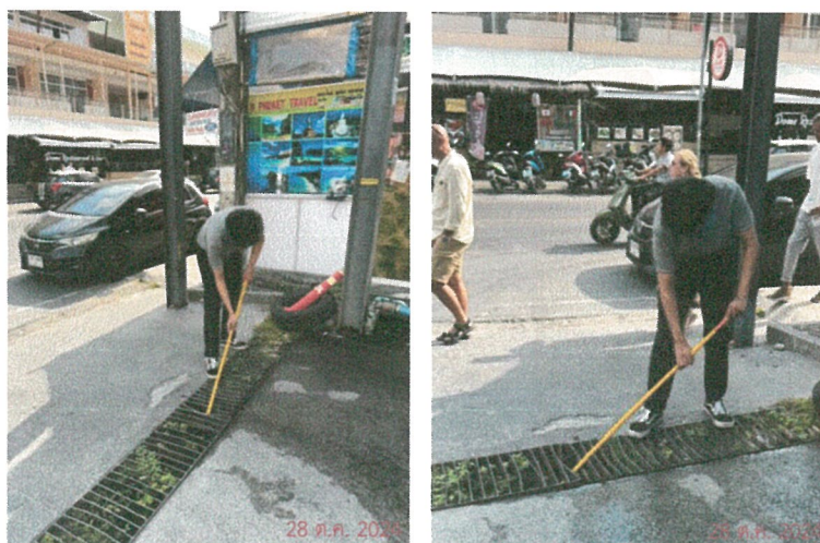
รูปภาพที่ 2.19 ขุดลอกตะกอน
